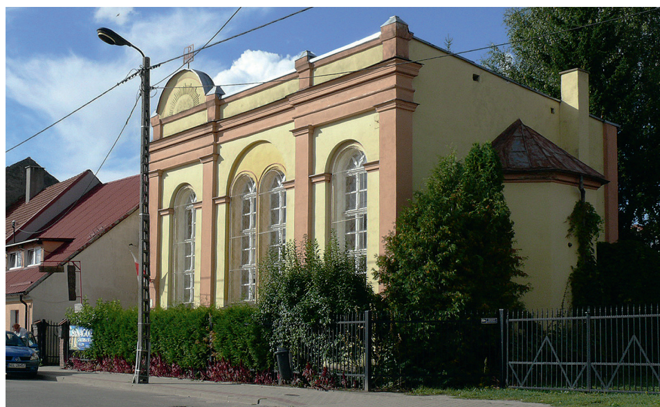
l: Wartenburg, ehemalige Synagoge/Barczewo, former synagogue (Photo: Kamila Storz, 2019)
