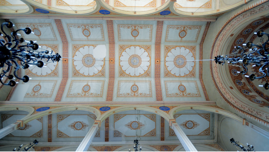
Synagoge Lengnau (1847, Restaurierung der Fassaden 1983–84) / Lengnau Synagogue (1847, façades restored in 1983–84), (Photos: U. Knufinke, 2017)
